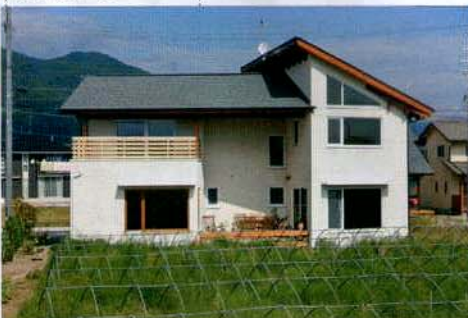
モデルハウス兼住宅の南側外観。冬の日射取得を優先し、開口部を大きくとっている
