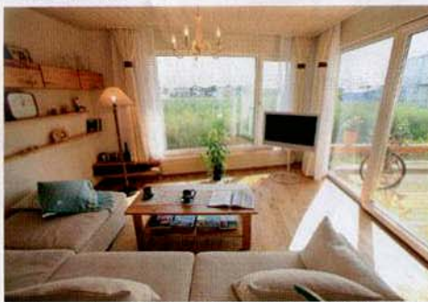
モデルハウス兼住宅の内観。透湿性・調湿性のある無垢の木や塗り壁を用い、水蒸気の移動を妨げない
