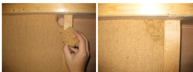
施工後は隙間が無いチェックし、あれば端材で埋めていく
