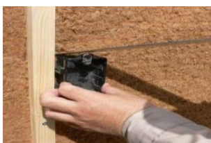
作業用カッターでコンセントの形に切り込みを入れる
