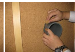
隙間に端材を詰める
