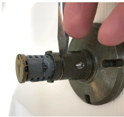
②シリンダーと座の 固定用パーツ上端に マイナスドライバー等を 画像のようにあてます。
