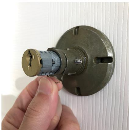
④固定用パーツを指で 掴んで、座から外します。
