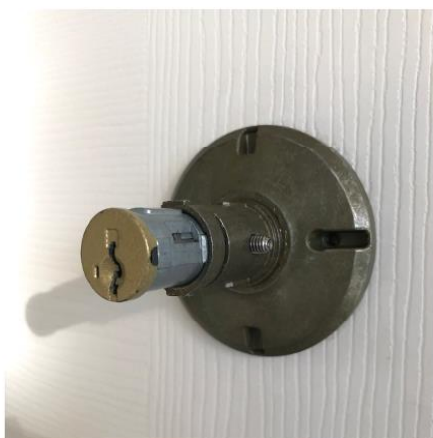
⑦シリンダーを正しい向きに して、座にセットします。
