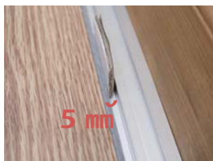
⑤ スペースを挟み、5mm 程度の隙間を空けて置き床を敷きます。
