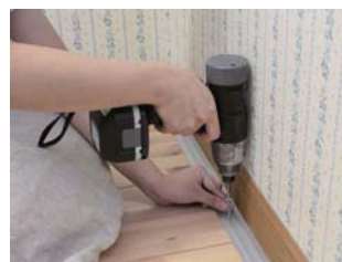
③ 受け台座を取り付けます。接着テープかビスで固定してください。
