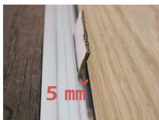
⑤ スペースを挟み、5mm 程度の隙間を空けて置き床を敷きます。
